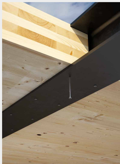
^ Verbindung einer gemischten Stahl-Holz-Konstruktion
